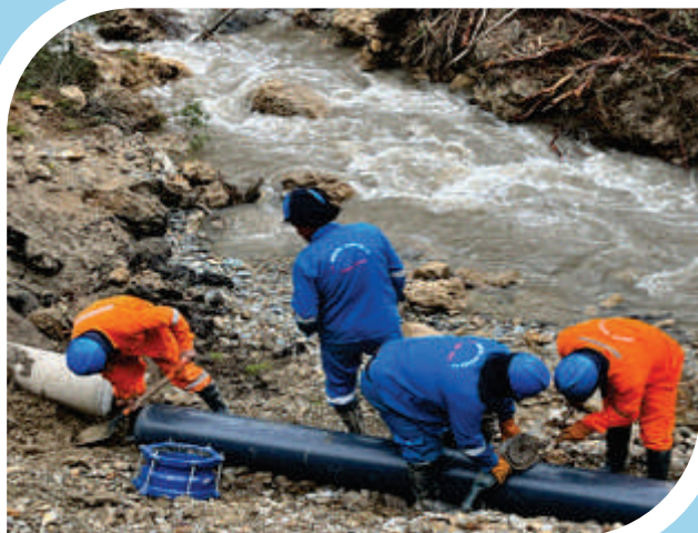
Personal operativo de la localidad de Jauja, realizando trabajos de reparación por emergencia en la línea de conducción de Quero.
