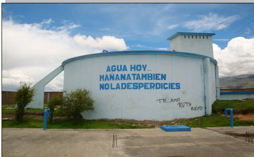
Foto N° 01.03.10: Reservorio apoyado y cisterna en el sector Wilka Ulo.
