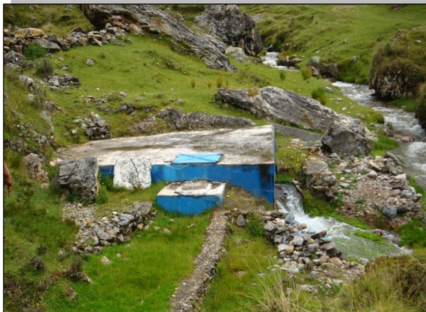
Foto N° 01.03.01: Captación del manantial Quero, al partir del cual se captan 45 lps aproximadamente.
