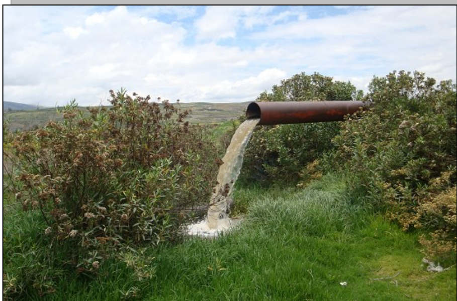
Foto N° 01.03.11: Emisor N° 1, con descarga de crudo en las riberas del Mantaro.
