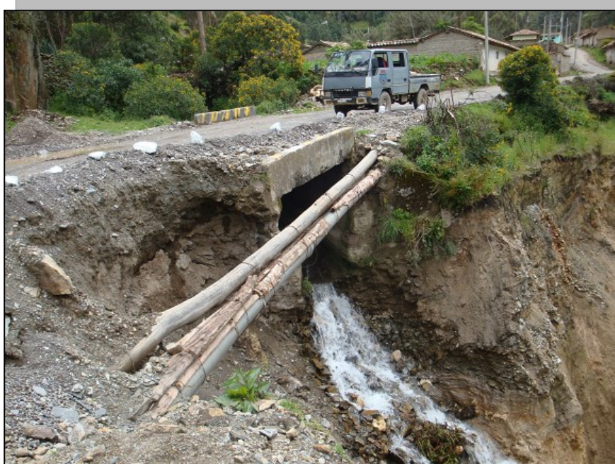
Foto N° 01.03.02: Línea de conducción de Quero, en un tramo instalado provisionalmente, afectada por deslizamientos estacionales en la zona.
