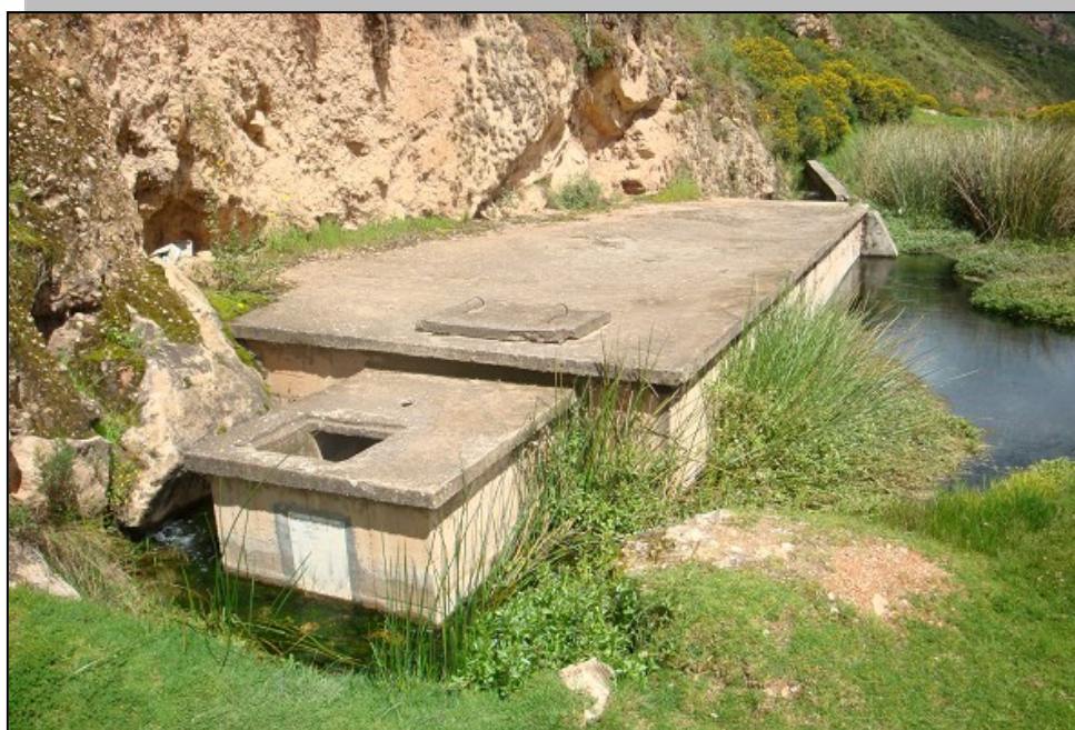
Foto N° 01.03.08: Captación sub superficial Coyllor, mediante sistema de ladera, principal fuente de abastecimiento de la localidad de Chupaca.
