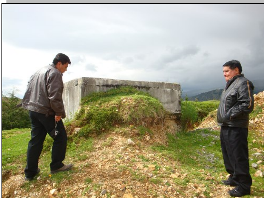
Foto N° 01.03.06: Cámara de repartición en la línea de conducción, no cuenta con un sistema de repartición de caudales.
